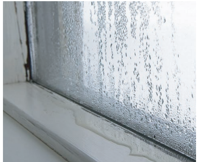
●窓ガラスとサッシの結露
